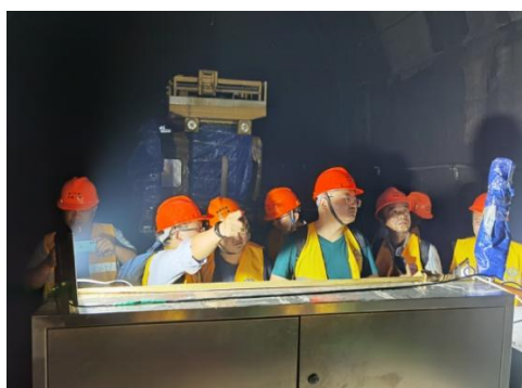
图 4-2 学徒参与设备现场安装调试
