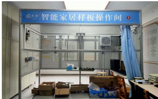
图 7-5 智能家居安装与维护实训平台
